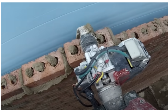
Hình 4. Robot Sam tự lấy vữa xây tường.
