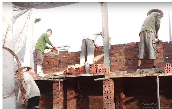
Hình 1. Công tác xây tường thủ công.
