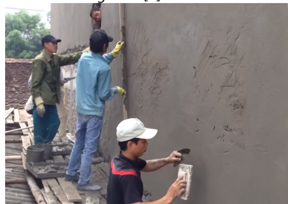
Hình 5. Trát tường thủ công.
