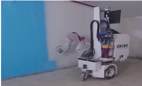
Hình 9. Robot sơn tường OKIBO.
