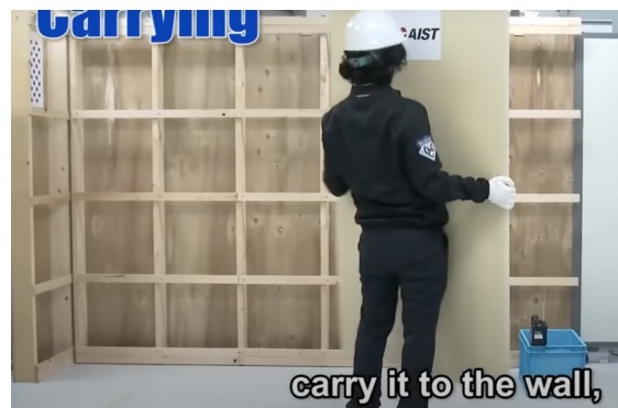
Hình 11. Đóng vách bằng thủ công.
